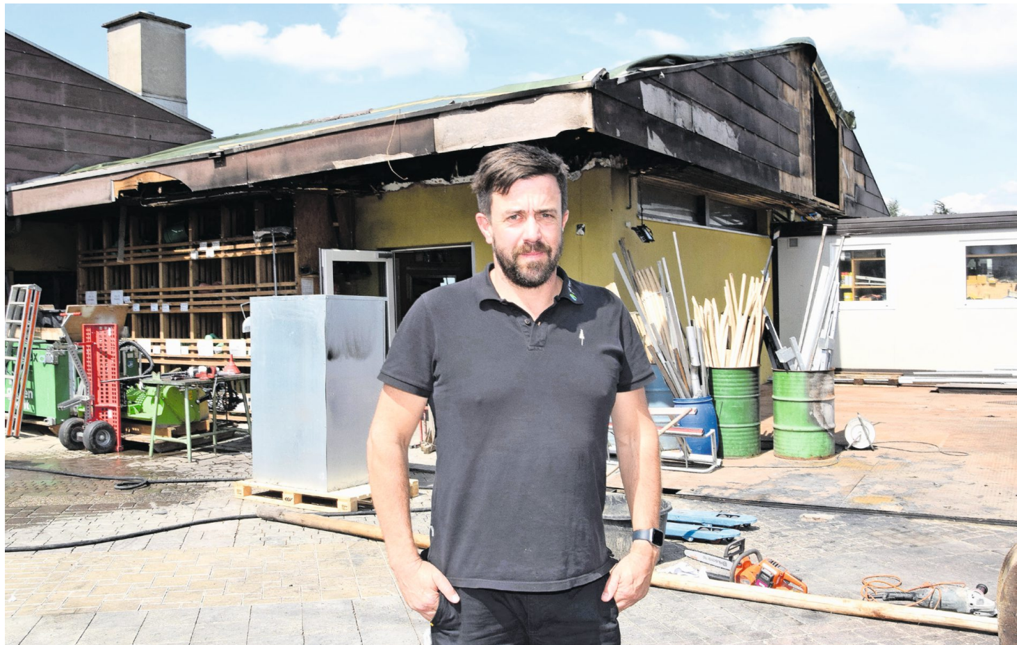
Geschäftsführer Claude Perrinjaquet zeigt die Stelle, an der sich der Unterstand befand. Auch das Dach des Hauptgebäudes wurde durch den Brand beschädigt.
