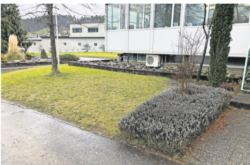
Beispiel 1: Eine Rasenfläche vor einem Firmengebäude vor (links) und nach der ökologischen Aufwertung.
